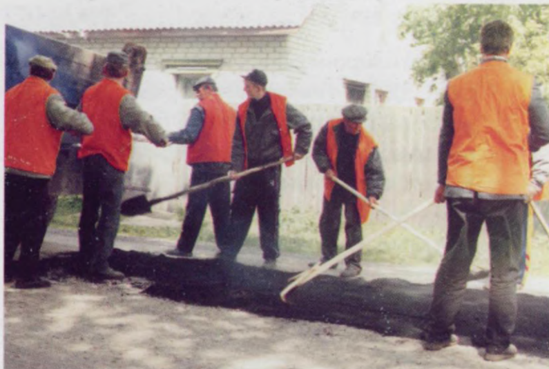
Ремонт дороги ДРСУ
